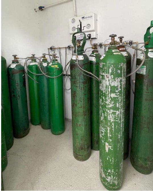
CENTRAL DE GASES (OXIGÊNIO E AR COMPRIMIDO)
