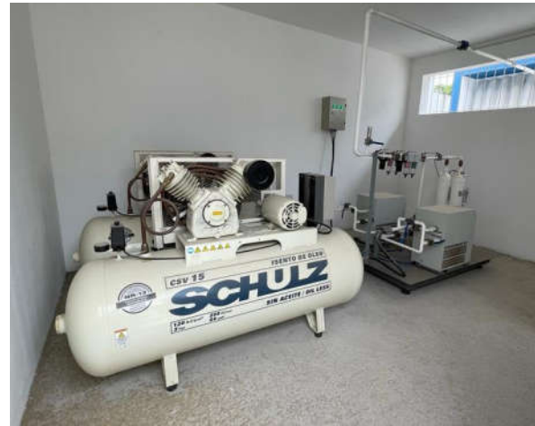
CENTRAL DE GASES (OXIGÊNIO E AR COMPRIMIDO)
